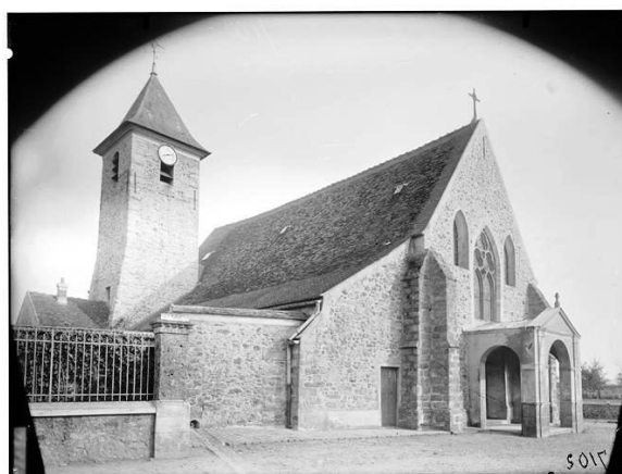
L'église de Ballainvilliers
