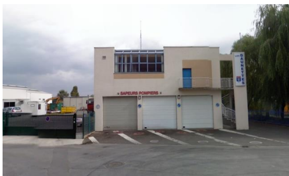
Centre de secours
